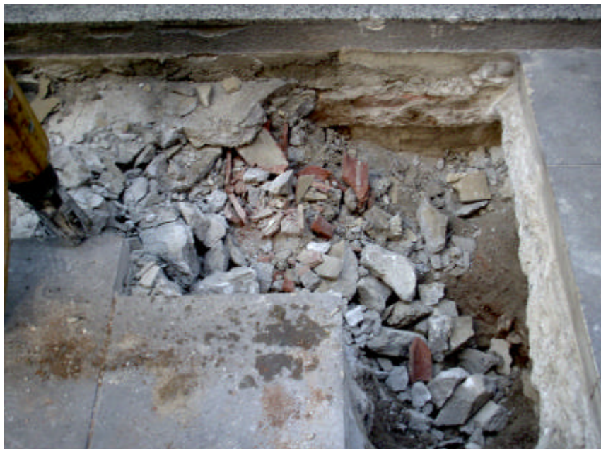
Foto. 7. Trencament del paviment (U.E. 100).
