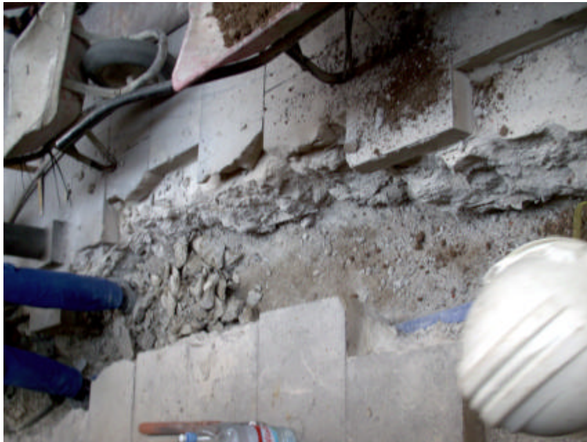
Foto. 6. Trencament del paviment (U.E. 100).
